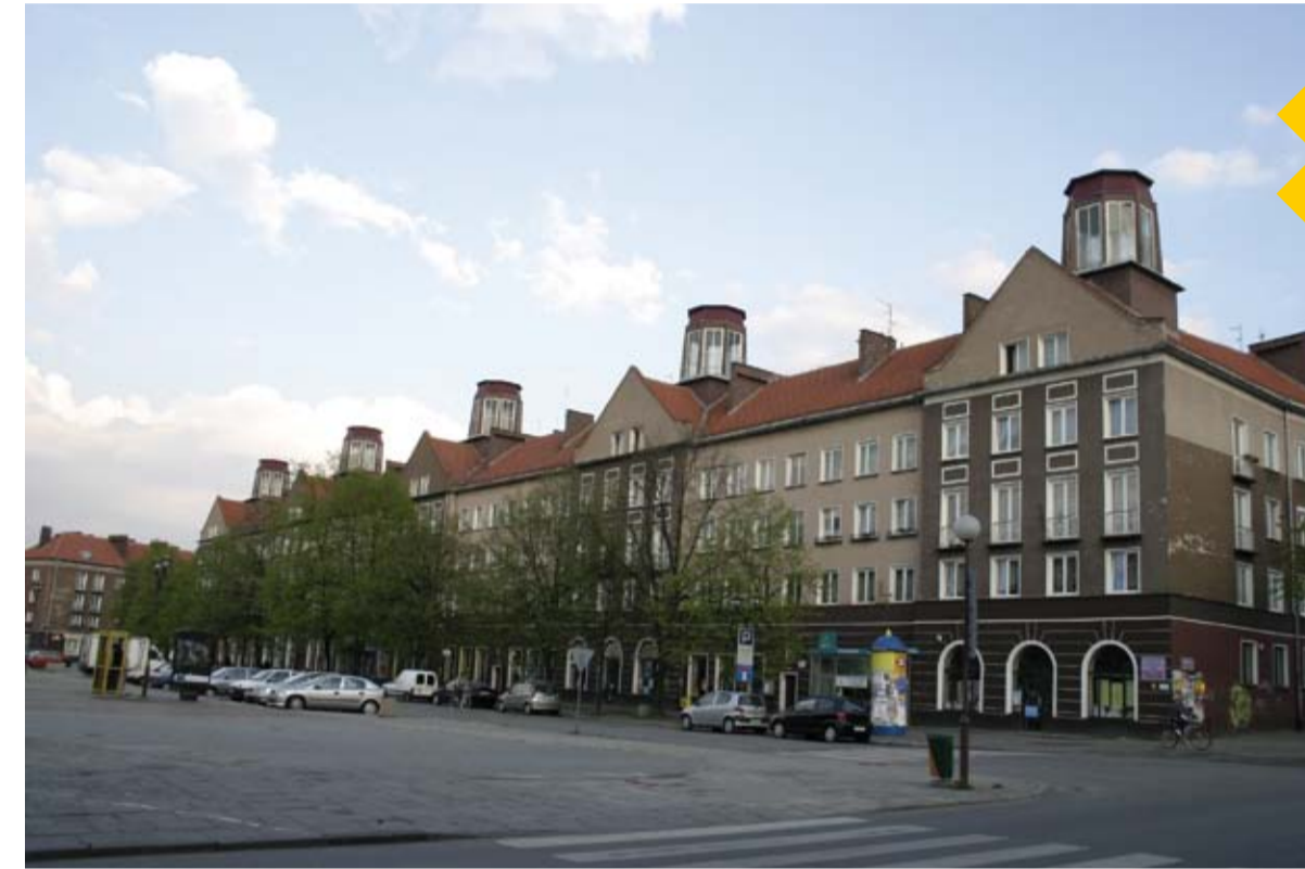
Plac Baczyńskiego przed modernizacją.
